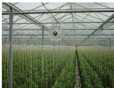
Рис.22. Способ 4. С помощью вентиляторов при закрытой теплице
